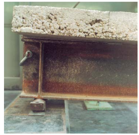
Fig. 32 Échantillon t1, dalle encore intégrée après l'affaissement de la poutre en acier 32
