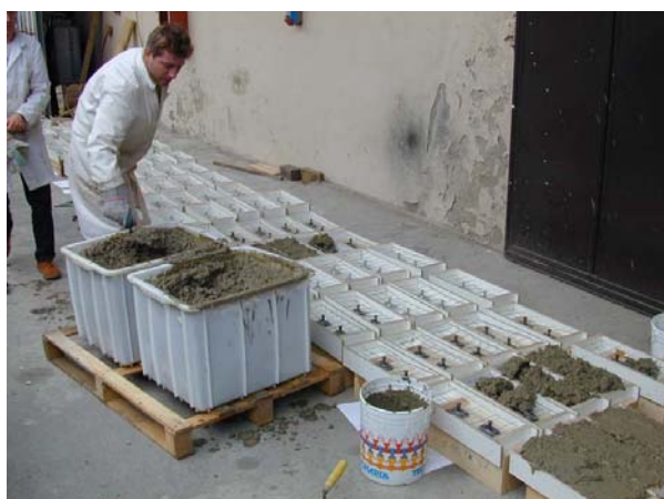
Photo 2 : Pose du béton
