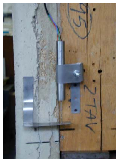
Photo 4 Détail du transducteur linéaire pour le relevé du fluage
