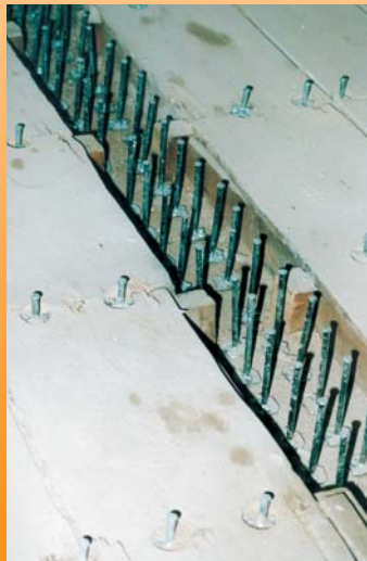
connecteur en contact direct avec la poutre principale et sur les solives secondaires
