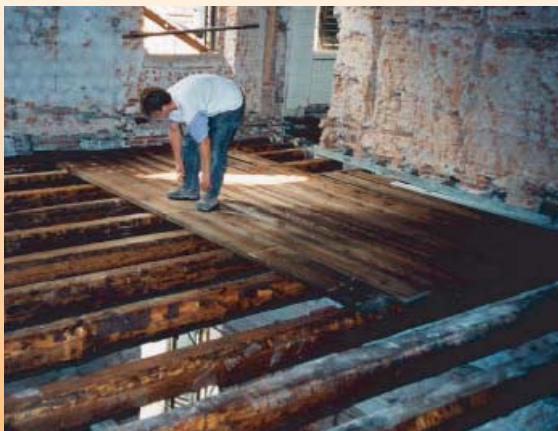
Après la pose des nouvelles poutres en bois dans les logements existants, le plancher supérieur a été posé et cloué.
