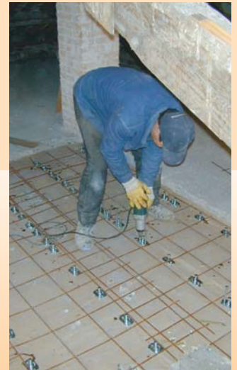
Fixation des vis des connecteurs avec une visseuse électrique à impulsions, avec insert hexagonal de 13 mm.
