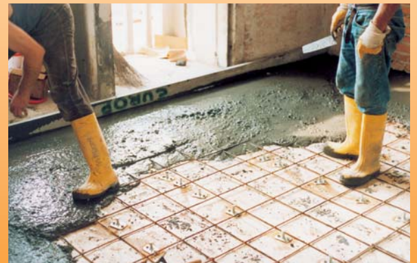
Dans la dalle en béton, un treillis électrosoudé adéquatement dimensionné a été posé. Sur la photo: réalisation de la coulée. Les planchers ont été préalablement étayés.
